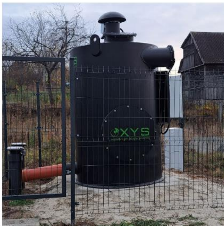
Filtr antyodorowy na studni rozprężnej w Fastach
