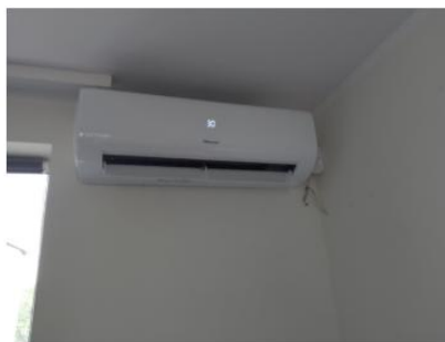
Remont świetlicy w Chrabołach
