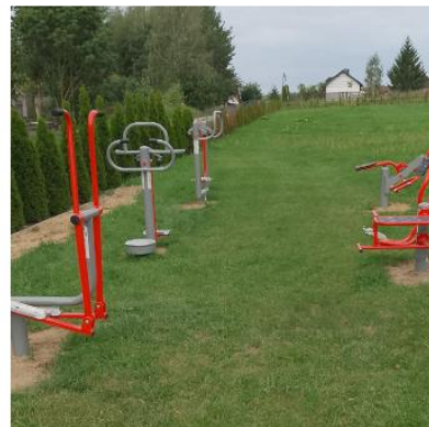
Budowa siłowni zewnętrznej
